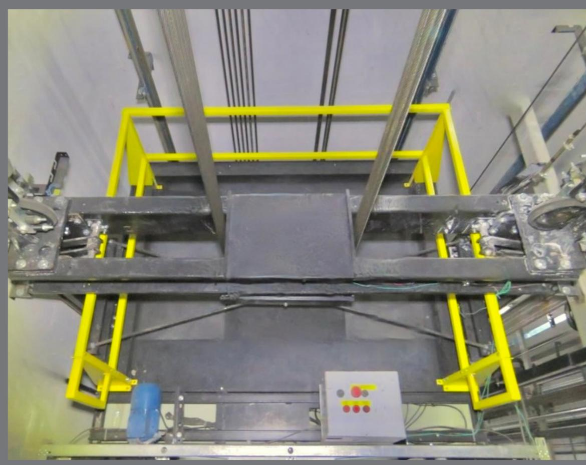
**Proteção no topo do carro em Aço Carbono, pintura cor amarelo Imperial**
